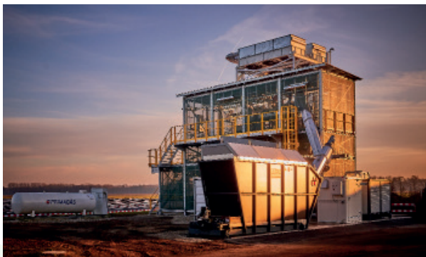
Unsere LX-Demonstrationsanlage am Standort der Biogas Aholting GmbH & Co. KG bei Straubing in Bayern.
